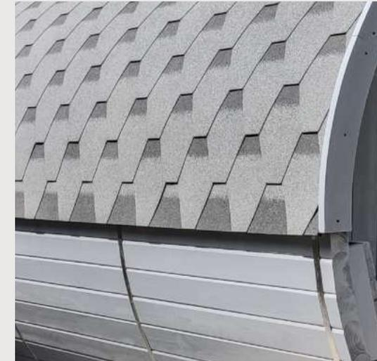
Dacheindeckung mittels Bitumenschindeln
